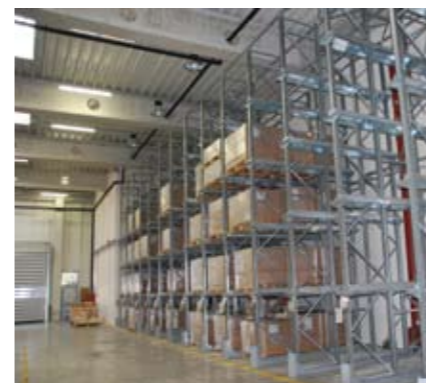
Drive-in regali v skladišču nepovratne embalaže, v katerih bo uskladiščeno 195 palet za destinacije, kamor se blago odpremlja s kontejnerji.
