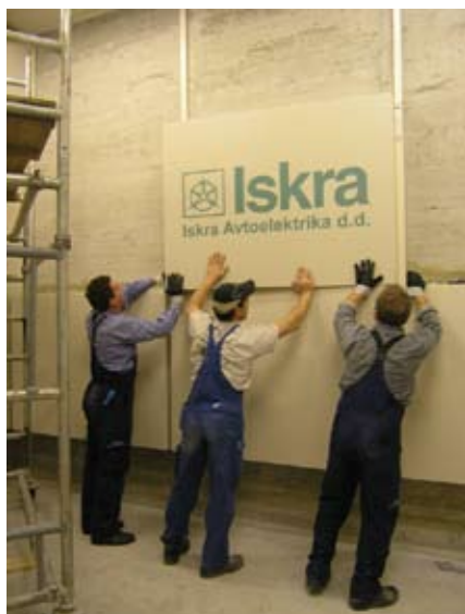
Montaža absorpcijskih plošč
